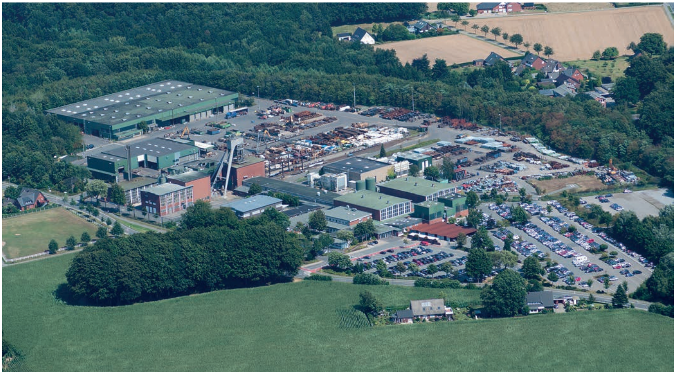
Luftbild Am Nordschacht
